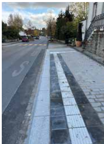
Mise en conformité de l'arrêt de bus et passage piéton à Goetzingen
