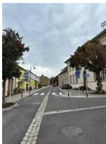
Renouvellement de la couche de roulement Rue de l'école à Koerich
