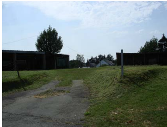
Photo 6 – Vue de la partie sud à partir de la rue du Bois
