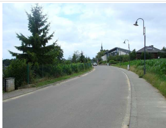
Photo 4 : Rue « Neie Wee », photo prise en direction du nord.
